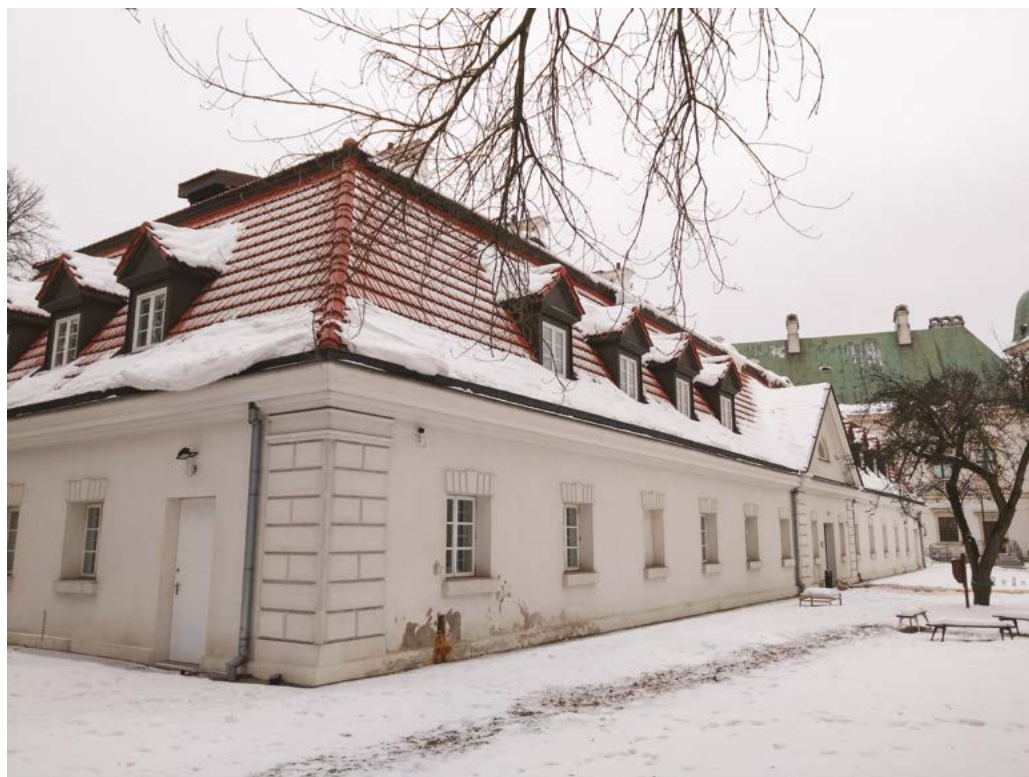
Widok od południowego wschodu
