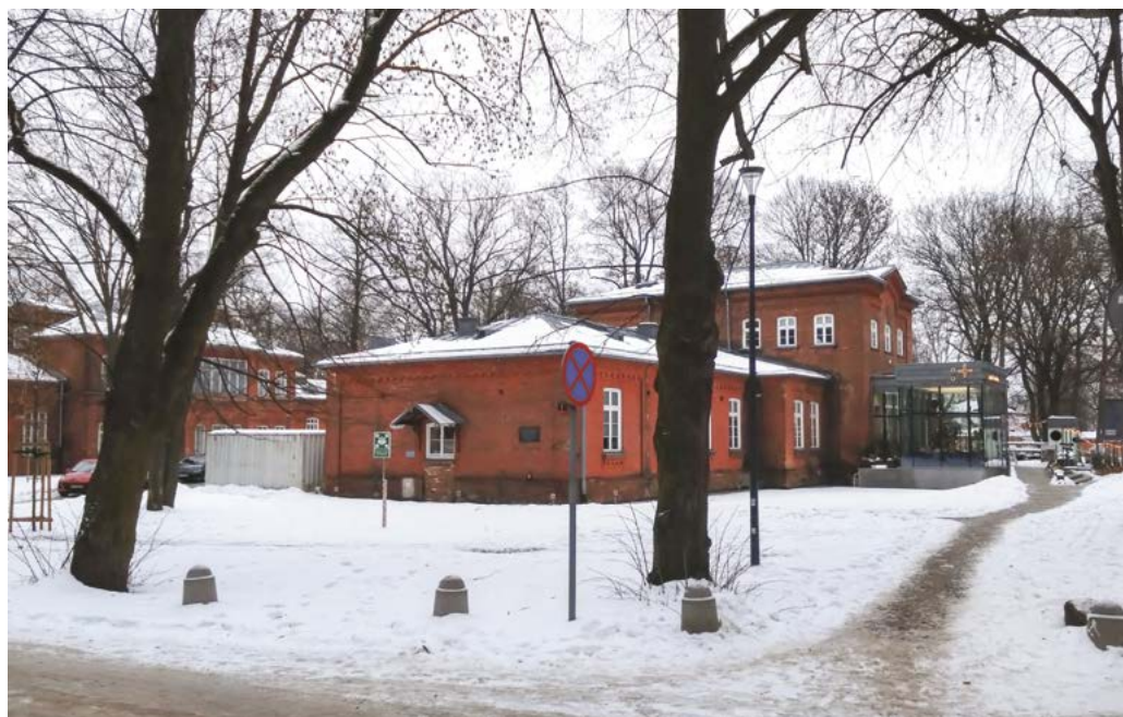
Widok od południowego zachodu
