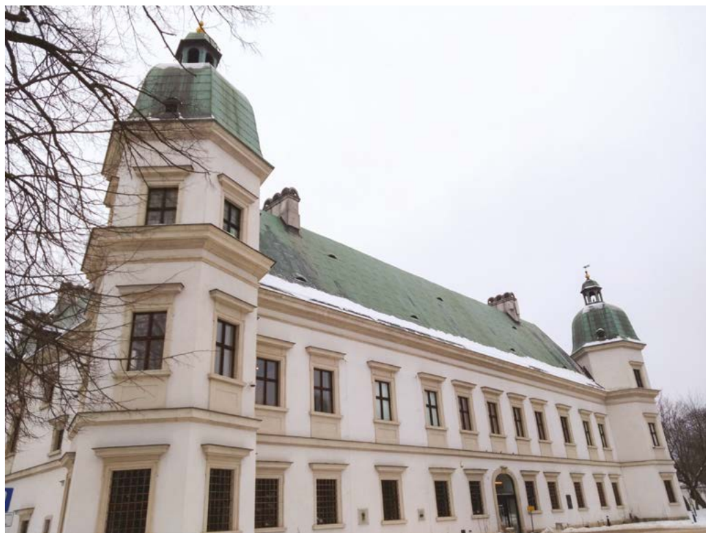
Widok fasady zachodniej
