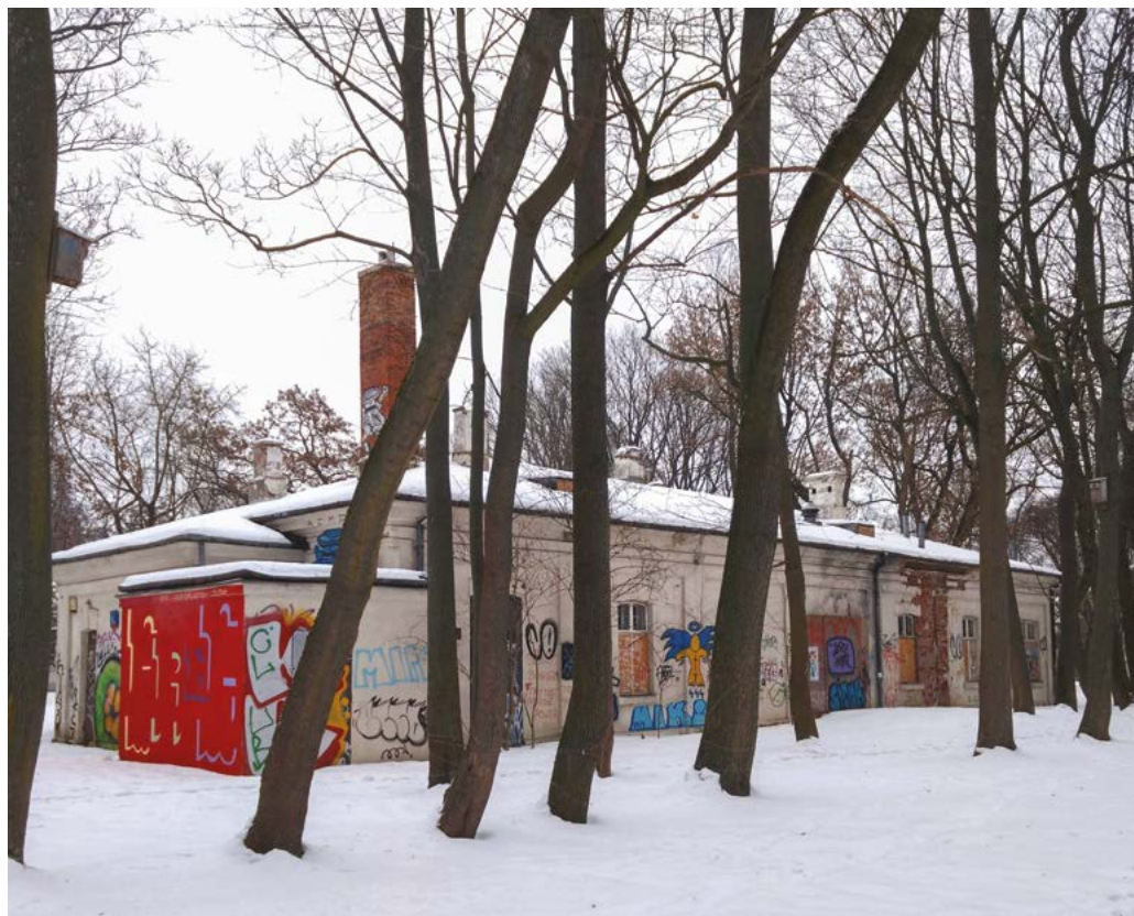
Widok od południowego zachodu
