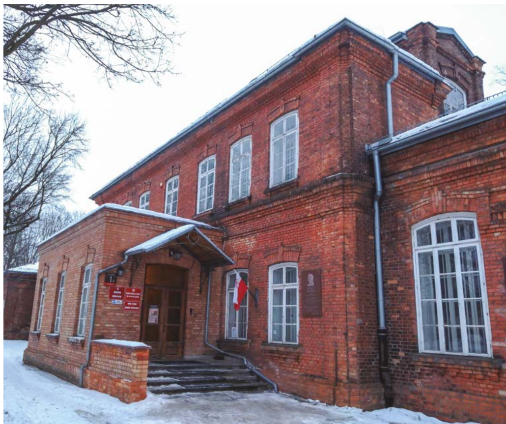
Widok od północnego zachodu
