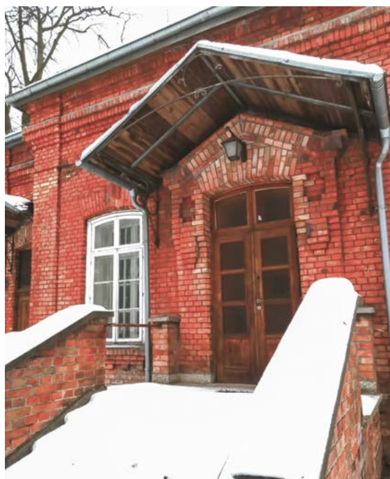
Detale wschodniego wejścia
