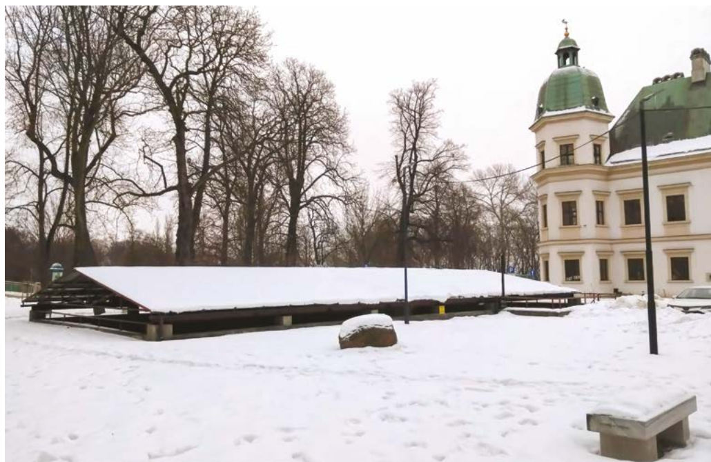
Północno-zachodnia wieża i daszek nad cysterną
