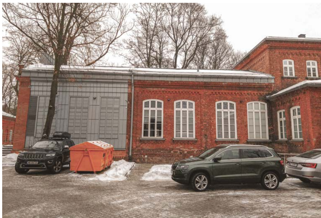
Rozbudowa od strony północnej z lat 2005–2006
